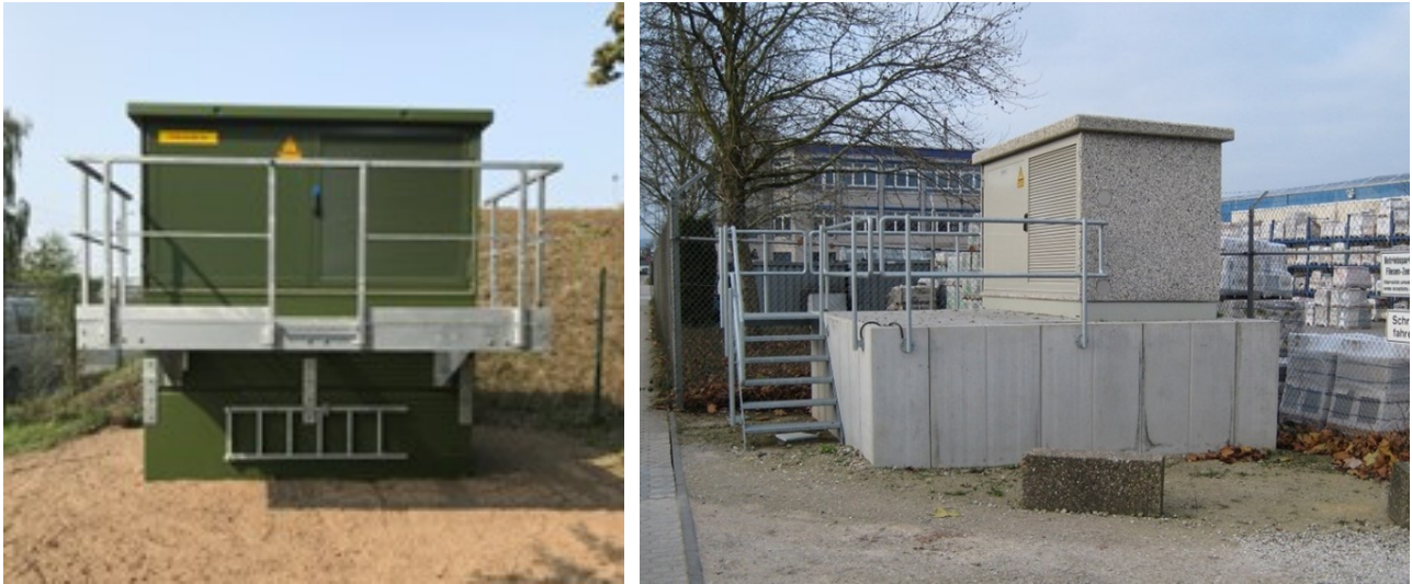
Abbildung 15: Ortsnetzstationen auf Sockeln 76
