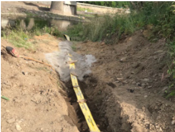
Wiederherstellung: Provisorische Versorgungsleitung zum Wiederherstellen von kritischer Infrastruktur (Quelle: Westnetz GmbH, 2021).
