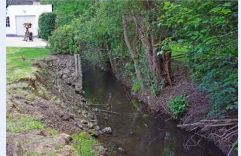
*Der betonierte Teil der bisherigen Ufermauer wurde beim Hochwasser im Juli 2021 zerstört. Hier wird nach hinten verlegt eine Uferböschung aufgebaut, wodurch eine Ausweitung des Bachprofils an einer Engstelle erfolgt.*
